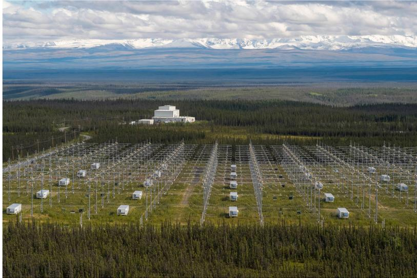
Установка по активному изучению ионосферы. Передатчик мощностью 3,6 МВт через антенну с управляемой диаграммой направленности излучает амплитудномодулированный сигнал в диапазоне коротких волн (также плавно менялась поляризация антенны)
